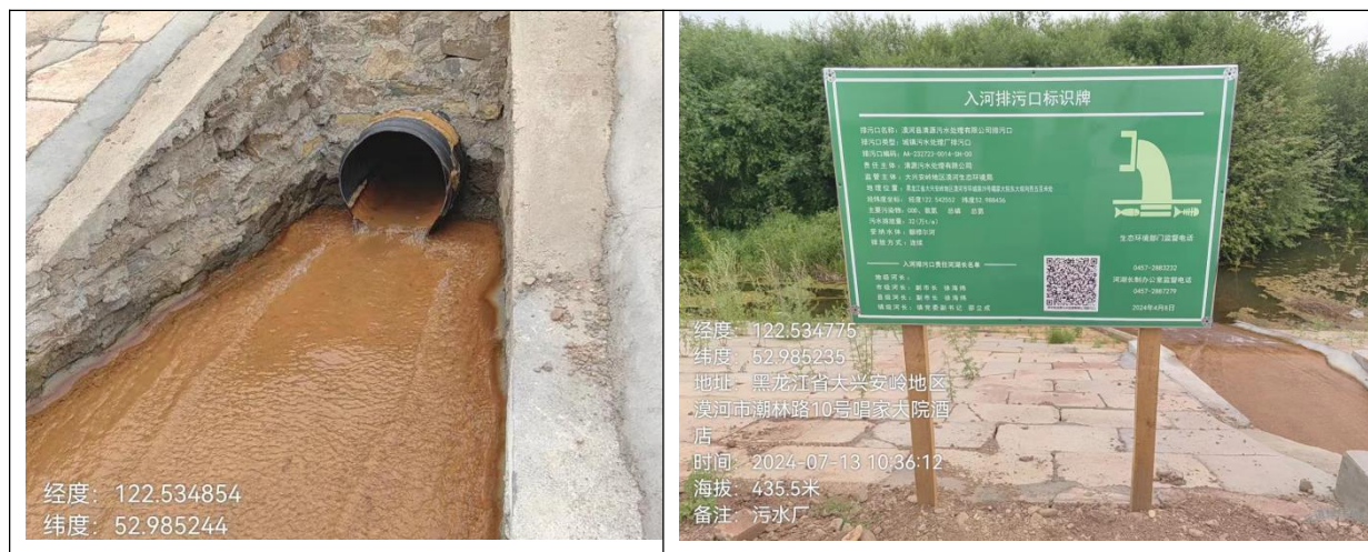
图 3.3-1 漠河市城镇污水处理厂排污口
